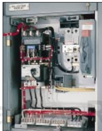
Arrancador con relevador de sobrecarga SMP-3 de estado sólido, conectado a DeviceNet
